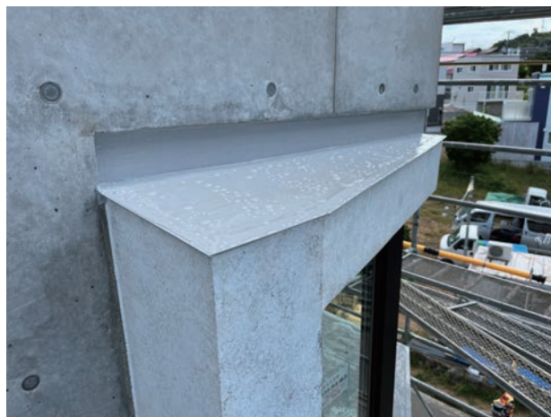
Photo14 庇先端にアルミフラットバー（水切）設置
