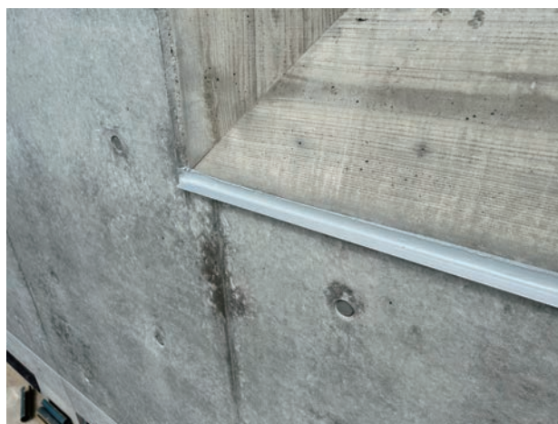
Photo15 壁面凹部にアルミLアングル（水切）設置
